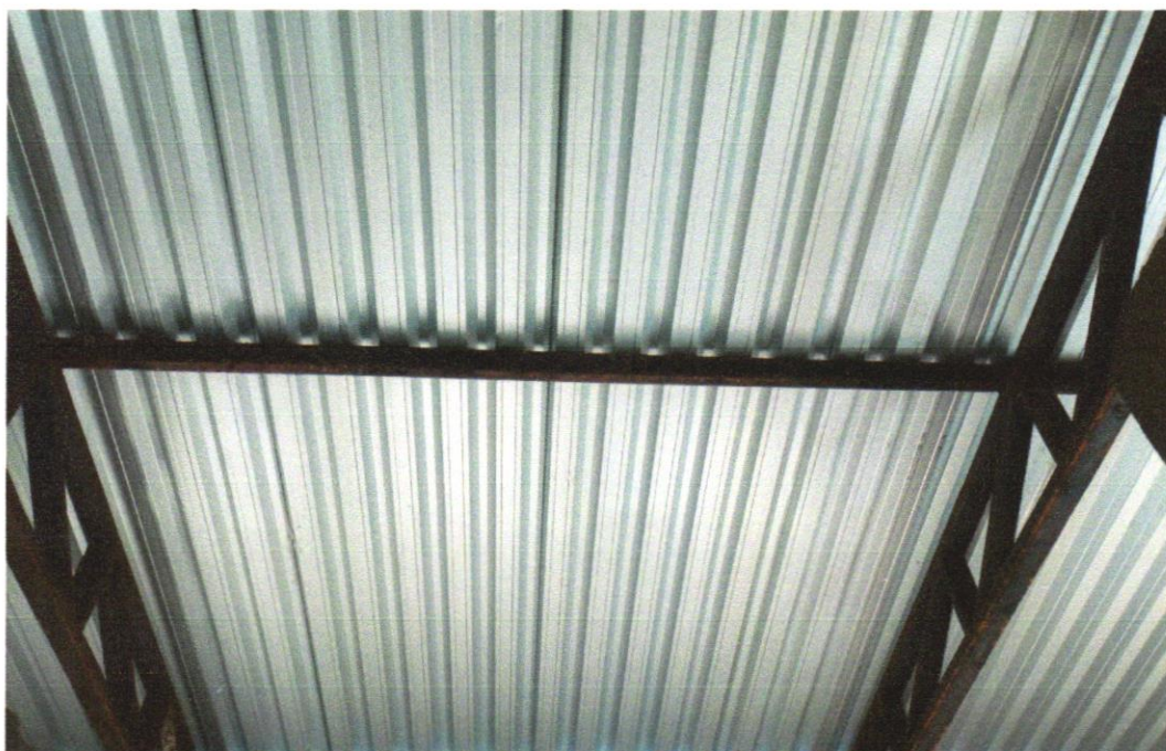
Foto 21 - TRAMA DE AÇO COMPOSTA POR TERÇAS PARA TELHADOS DE ATÉ 2 ÁGUAS PARA TELHA ONDULADA DE FIBROCIMENTO, METÁLICA, PLÁSTICA OU TERMOACÚSTICA, INCLUSO TRANSPORTE VERTICAL. AF_07/2019
