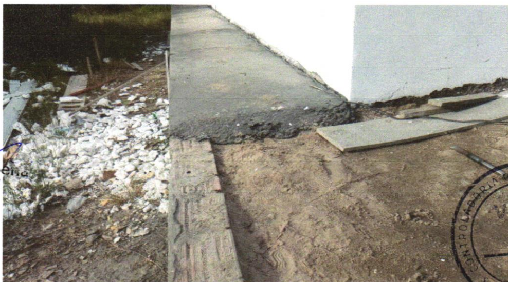
FOTO 04 - EXECUÇÃO DE PASSEIO (CALÇADA) OU PISO DE CONCRETO COM CONCRETO MOLDADO IN LOCO, USINADO, ACABAMENTO CONVENCIONAL, NÃO ARMADO. AF_07/2016
