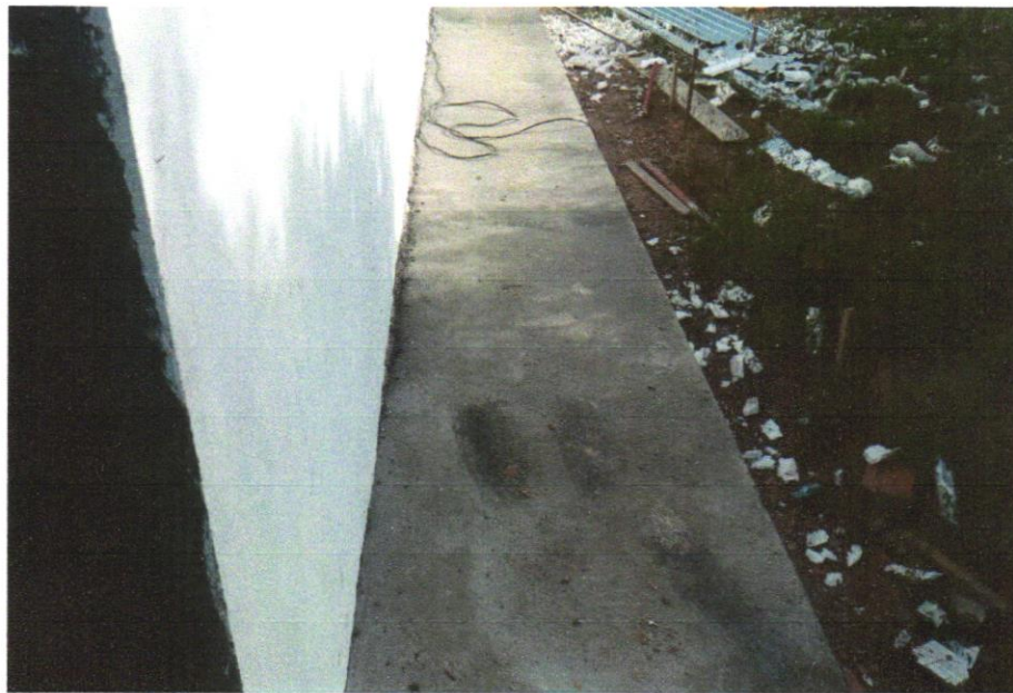
FOTO 03 - EXECUÇÃO DE PASSEIO (CALÇADA) OU PISO DE CONCRETO COM CONCRETO MOLDADO IN LOCO, USINADO, ACABAMENTO CONVENCIONAL, NÃO ARMADO. AF_07/2016
