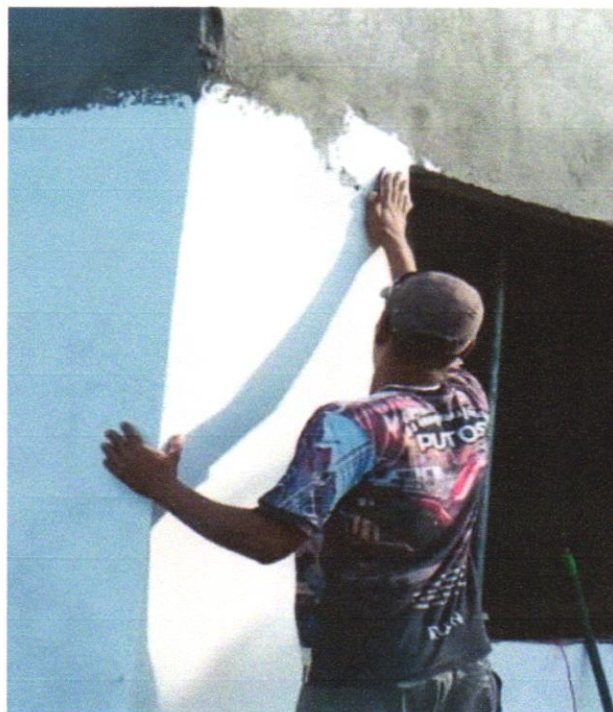
Foto 14- APLICAÇÃO E LIXAMENTO DE MASSA LÁTEX EM PAREDES, UMA DEMÃO. AF_06/2014
