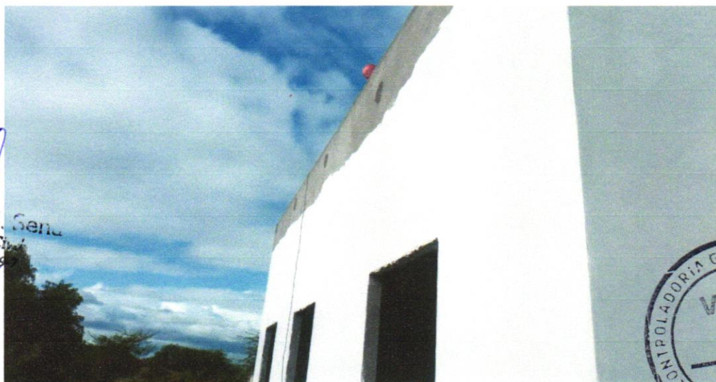
FOTO 02 – EM GRANITO, LARGURA 15 CM, ESPESSURA 2,0 CM. AF_09/2020
