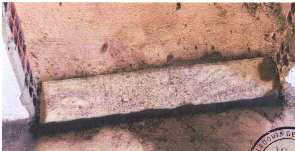
FOTO 02 SOLEIRA EM GRANITO, LARGURA 15 CM, ESPESSURA 2,0 CM. AF_09/2020
