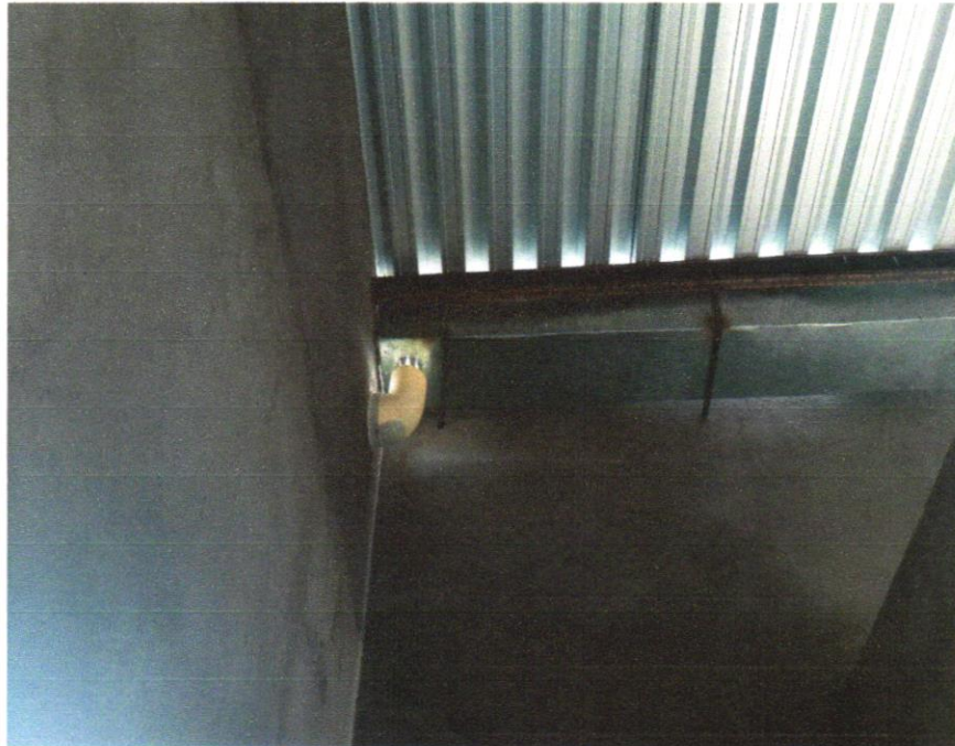
Foto 29 - CALHA EM CHAPA DE AÇO GALVANIZADO NÚMERO 24, DESENVOLVIMENTO DE 100 CM, INCLUSO TRANSPORTE VERTICAL. AF_07/2019
