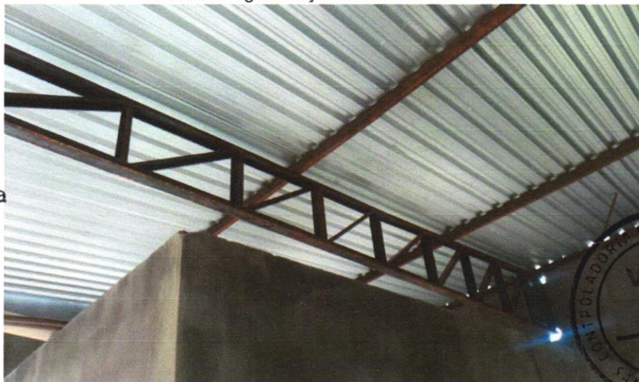
Foto 20 - FABRICAÇÃO E INSTALAÇÃO DE TESOURA INTEIRA EM AÇO, VÃO DE 10 M, PARA TELHA ONDULADA DE FIBROCIMENTO, METÁLICA, PLÁSTICA OU TERMOACÚSTICA, INCLUSO IÇAMENTO. AF_12/2015
