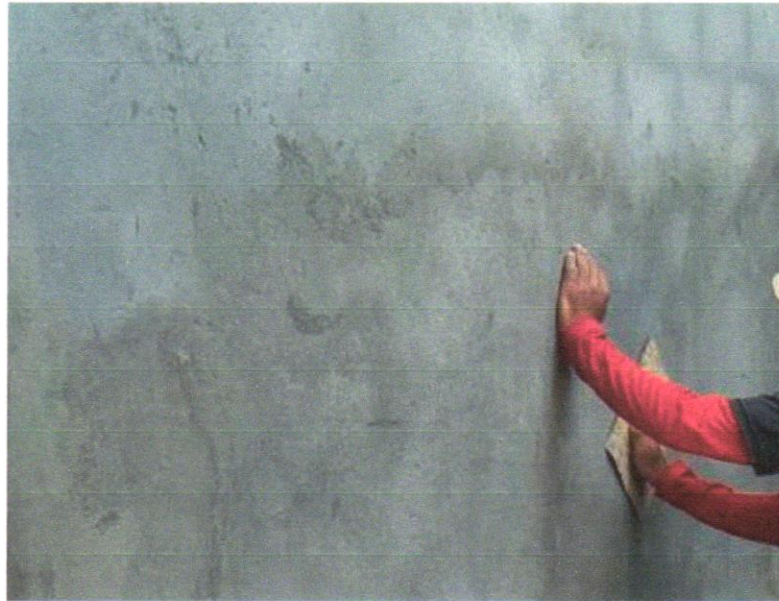
Foto 13 - Preparo de superfície com lixamento de paredes e tetos
