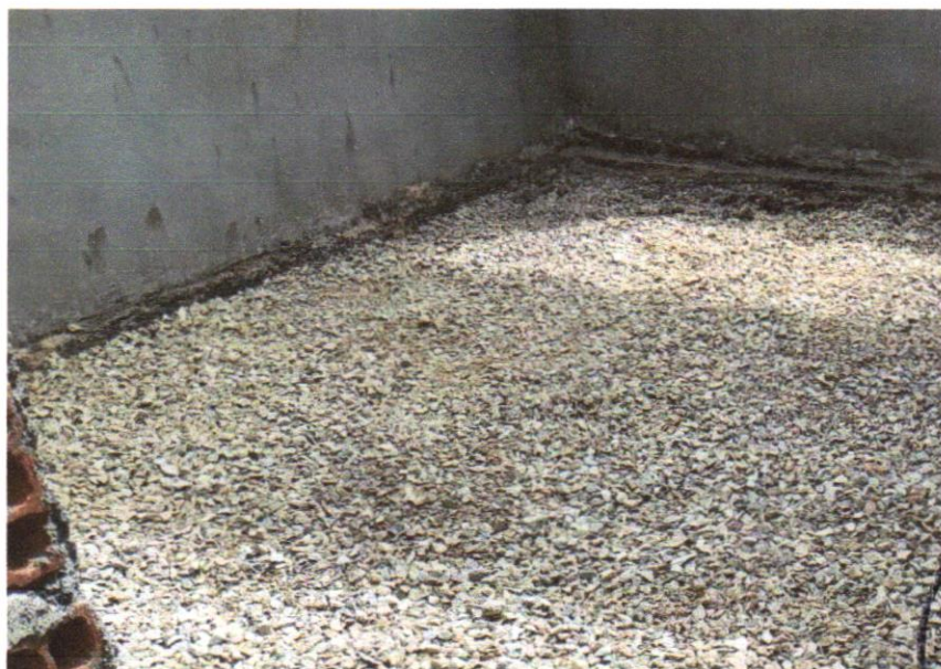
FOTO 08 – Lastro de brita graduada apiloada e=10cm
