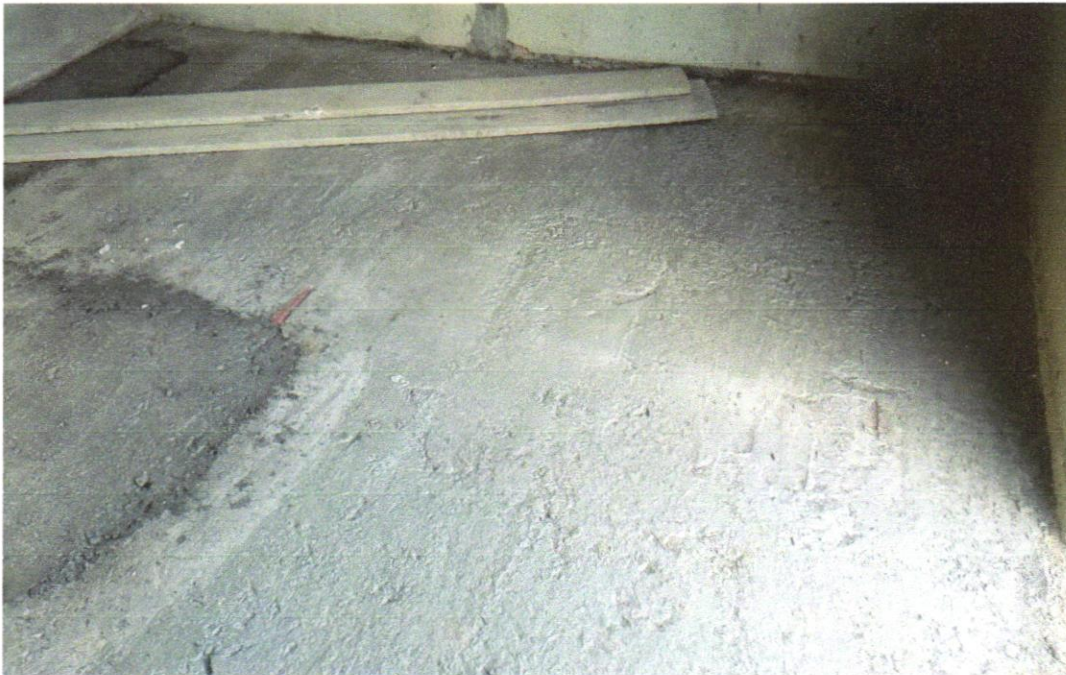
Foto 15 - PISO EM CONCRETO 20 MPA PREPARO MECÂNICO, ESPESSURA 7CM. AF_09/2020
