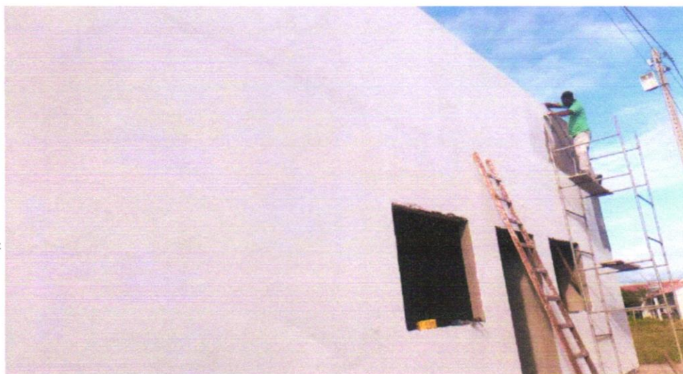
FOTO 01 – APLICAÇÃO E LIXAMENTO DE MASSA LÁTEX EM PAREDES, UMA DEMÃO. AF_06/2014
