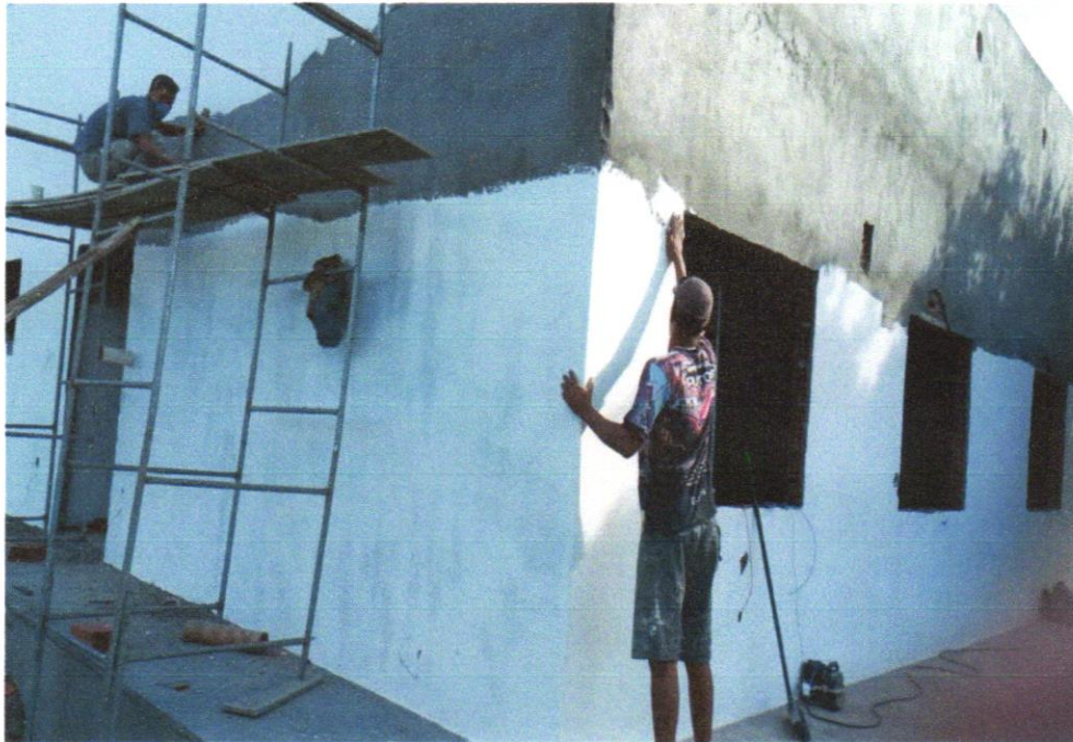
FOTO 07 - Preparo de superfície com lixamento de paredes e tetos
