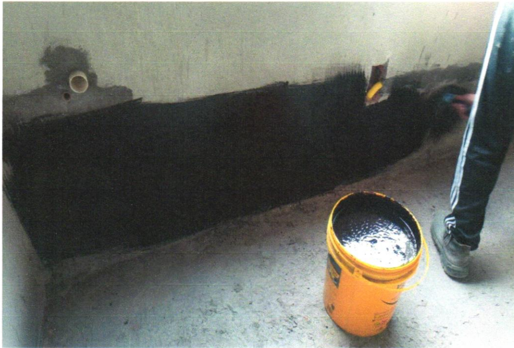
Foto 11 - IMPERMEABILIZAÇÃO DE SUPERFÍCIE COM MANTA ASFÁLTICA, UMA CAMADA, INCLUSIVE APLICAÇÃO DE PRIMER ASFÁLTICO, E=3MM. AF_06/2018
