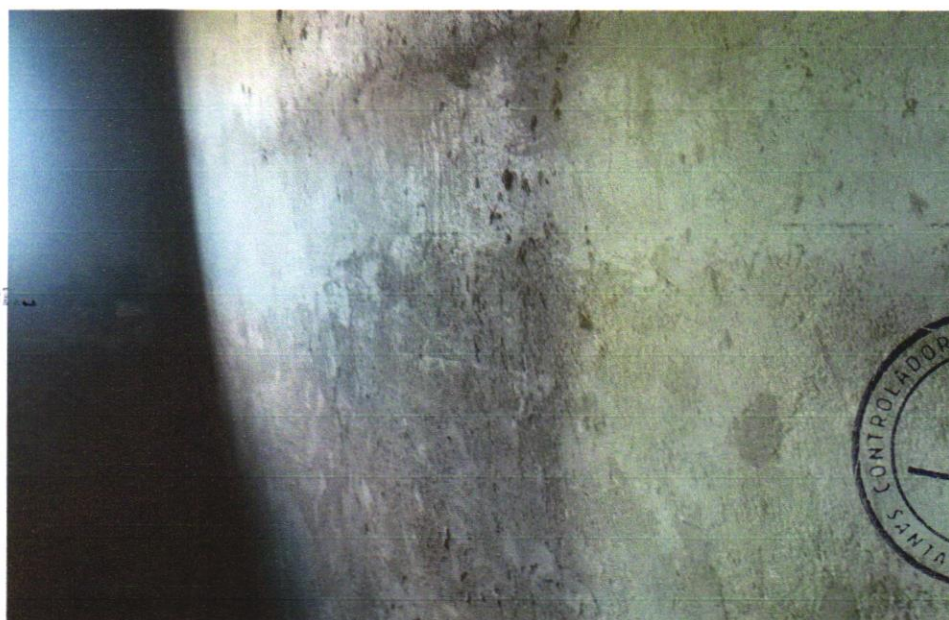
FOTO 22 - MASSA ÚNICA, PARA RECEBIMENTO DE PINTURA, EM ARGAMASSA TRAÇO 1:2:8, PREPARO MANUAL, APLICADA MANUALMENTE EM FACES INTERNAS DE PAREDES, ESPESSURA DE 10MM, COM EXECUÇÃO DE TALISCAS. AF_06/2014
