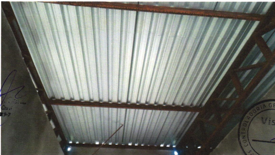
Foto 12 - TELHAMENTO COM TELHA METÁLICA TERMOACÚSTICA E = 30 MM, COM ATÉ 2 ÁGUAS, INCLUSO IÇAMENTO. AF_07/2019 TELHAMENTO COM TELHA METÁLICA TERMOACÚSTICA E = 30 MM, COM ATÉ 2 ÁGUAS, INCLUSO IÇAMENTO. AF_07/2019
