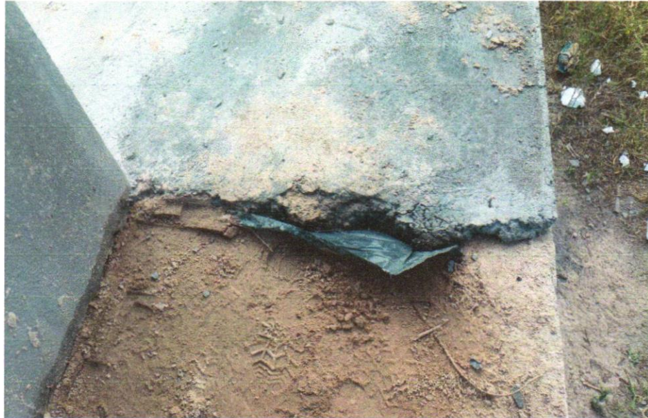
Foto 23 - APLICAÇÃO DE LONA PLÁSTICA PARA EXECUÇÃO DE PAVIMENTOS DE CONCRETO. AF_04/2022
