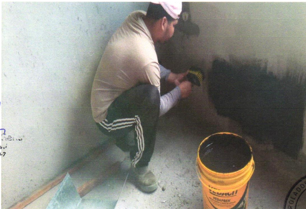
Foto 10 - IMPERMEABILIZAÇÃO DE SUPERFÍCIE COM MANTA ASFÁLTICA, UMA CAMADA INCLUSIVE APLICAÇÃO DE PRIMER ASFÁLTICO, E=3MM. AF_06/2018
