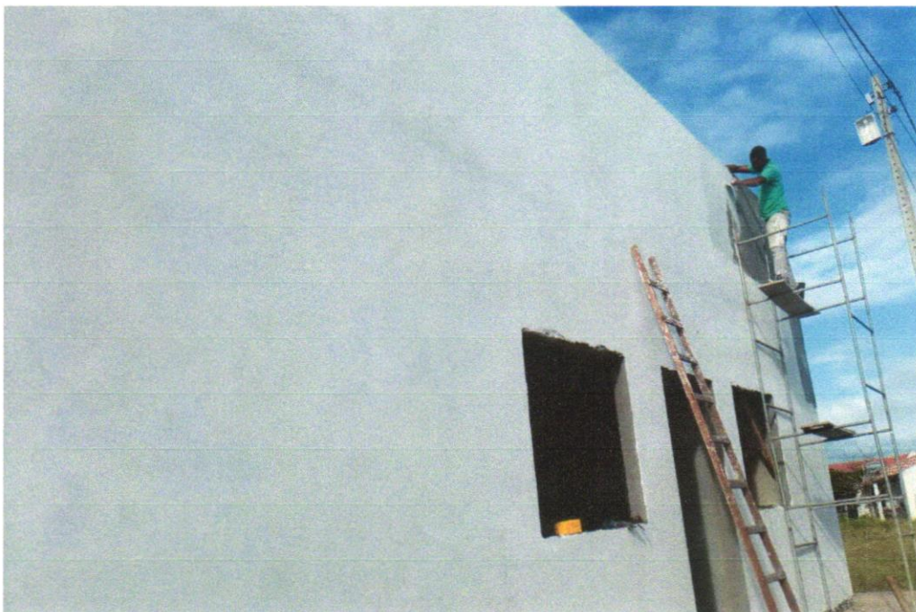
FOTO 01 – APLICAÇÃO E LIXAMENTO DE MASSA LÁTEX EM PAREDES, UMA DEMÃO. AF_06/2014
