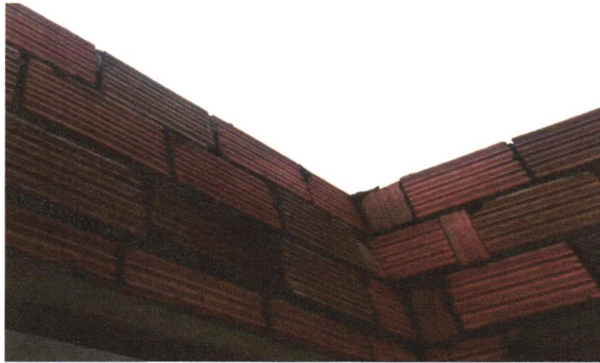
Foto 27 - ALVENARIA DE VEDAÇÃO DE BLOCOS CERÂMICOS FURADOS NA VERTICAL DE 9X19X39CM (ESPESSURA 9CM) DE PAREDES COM ÁREA LÍQUIDA MAIOR OU IGUAL A 6M 2 COM VÃOS E ARGAMASSA DE ASSENTAMENTO COM PREPARO EM BETONEIRA. AF_06/2014
