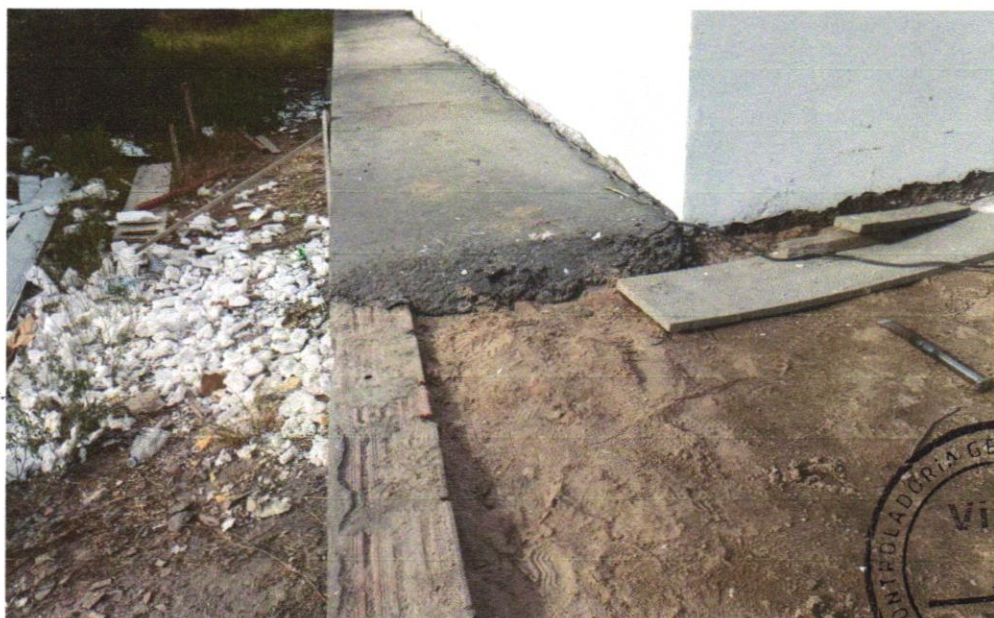
FOTO 24 - EXECUÇÃO DE PASSEIO (CALÇADA) OU PISO DE CONCRETO COM CONCRETO MOLDADO IN LOCO, USINADO, ACABAMENTO CONVENCIONAL, NÃO ARMADO. AF_07/2016
